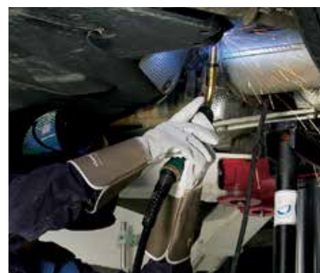
Control de ajuste de los parámetros de soldadura con el diálogo de la antorcha
